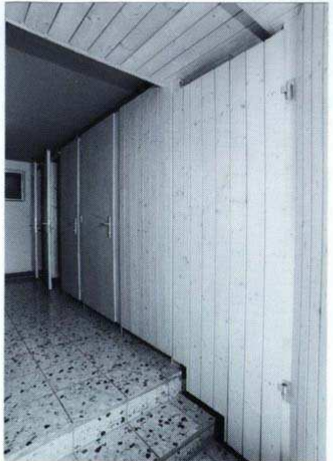
WC-Anlagen und Einzelwaschkabine
